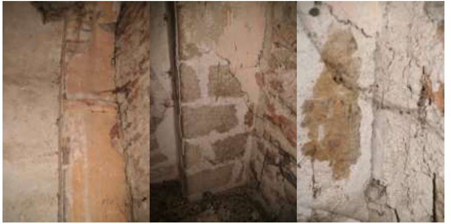
Détails de la jonction arc doubleau/mur est de la tour-porche
