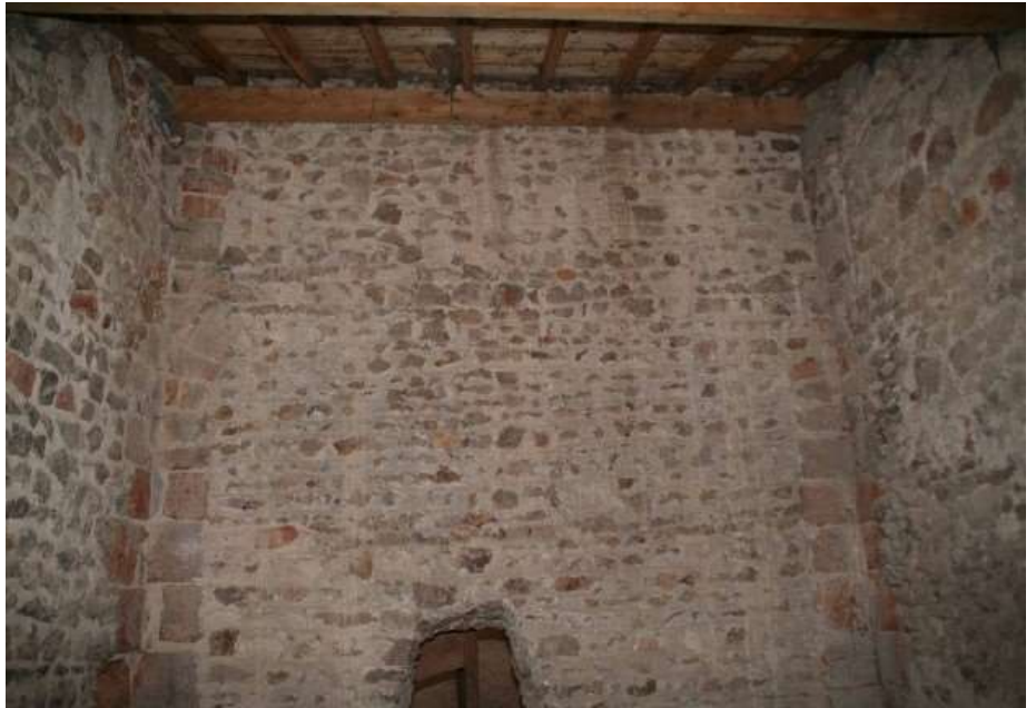
Mur Est de l'ancienne tribune
