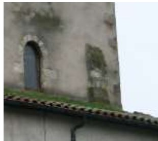
Contrefort Nord-Ouest du mur gouttereau de la nef
