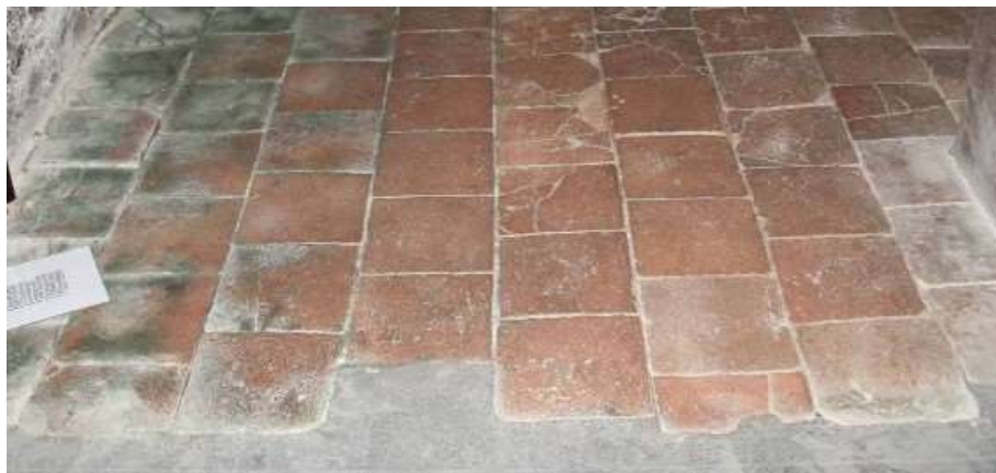
Sol en carreaux de terre cuite et ciment du bas-côté Nord
