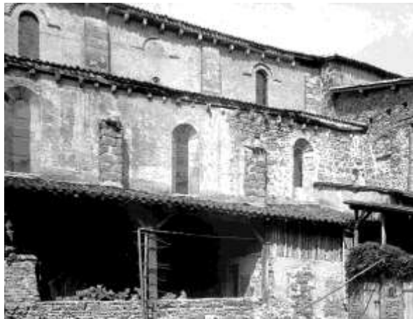
Elévation Sud en 1920
